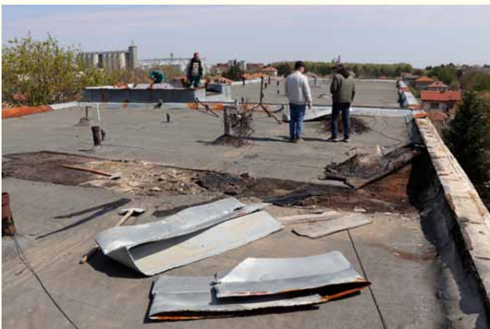
Ремонтът на покрива е все още в начална фаза.
