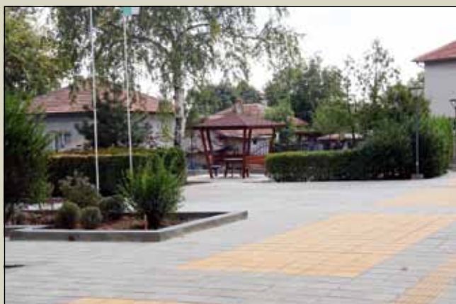
Проект „Ремонт на прилежащо пространство на Ученическо общежитие гр. Генерал Тошево“
