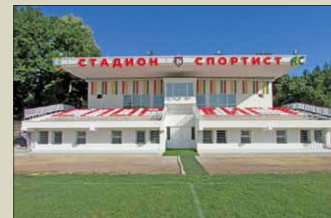
Завършен първи етап по проект „Ремонтни работи на обществена сграда към стадион „Спортист“ гр. Генерал Тошево
