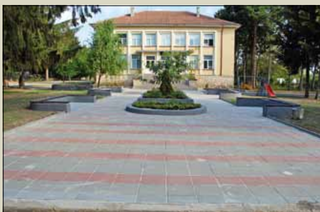
Ремонтираният площад пред сградата на НЧ „Нов живот – 1941“ в село Преселенци
