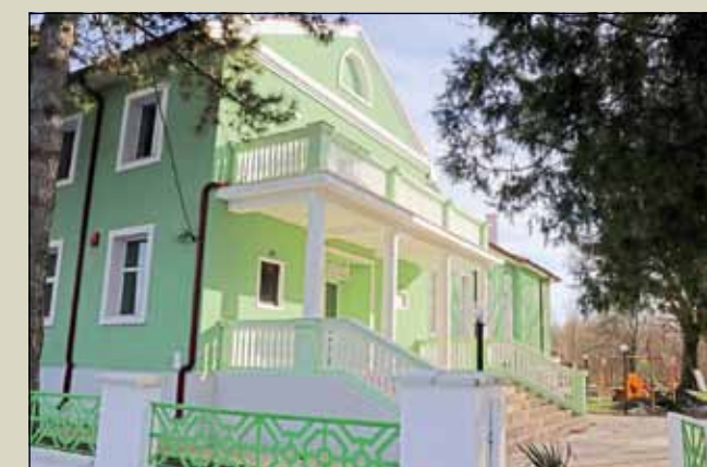
Ремонтираната сграда на НЧ „Дора Габе - 1940“ в с. Дъбовик по проект „Развитие и популяризиране на общото наследство“, BSB1010
