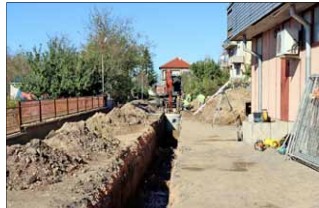
Ремонтните дейности на ул. „Отец Паисий“ вървят с пълна сила.
