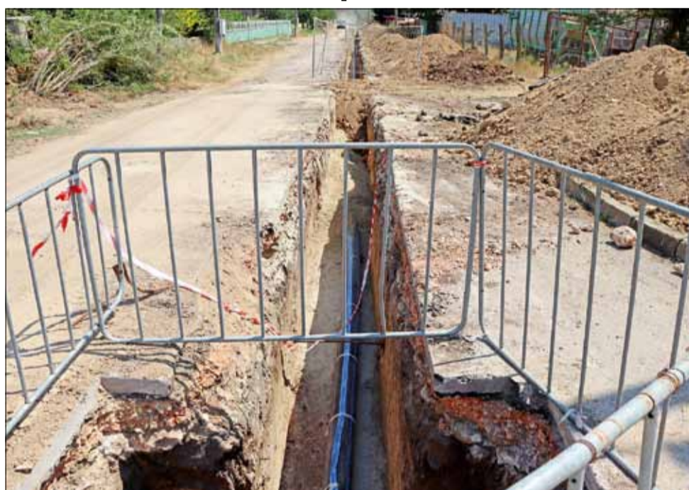
Подмяната на водопроводи върви паралелно на няколко улици в различните села.
