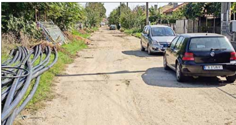
Водопроводът по ул. „Леонти Бакларов“ е вече подменен. Сега се работи на улиците „Стара планина“ и „Отец Паисий“.
