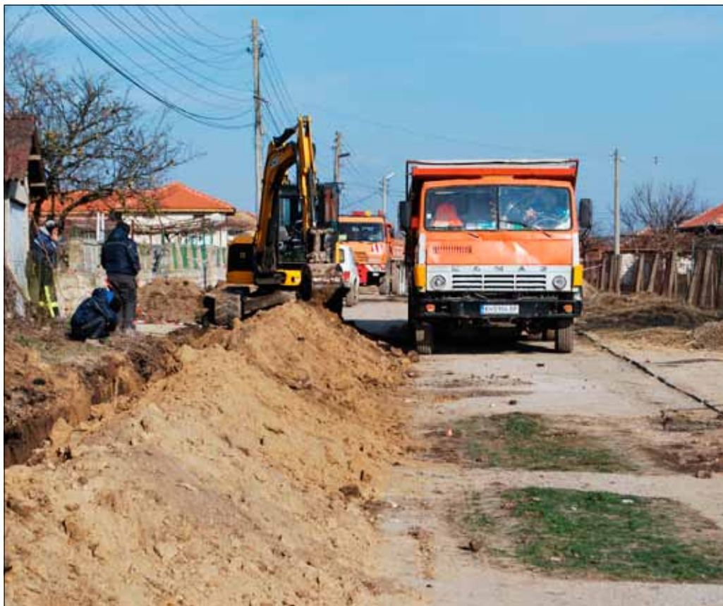
Усилената работа по подмяна на водопроводи на територията на цялата община продължава.
