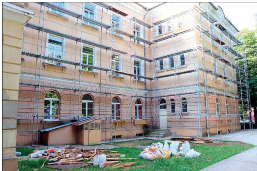
Дългоочакваният ремонт на сградата на СУ „Никола Й. Вапцаров“ се извършва с бързи темпове.
