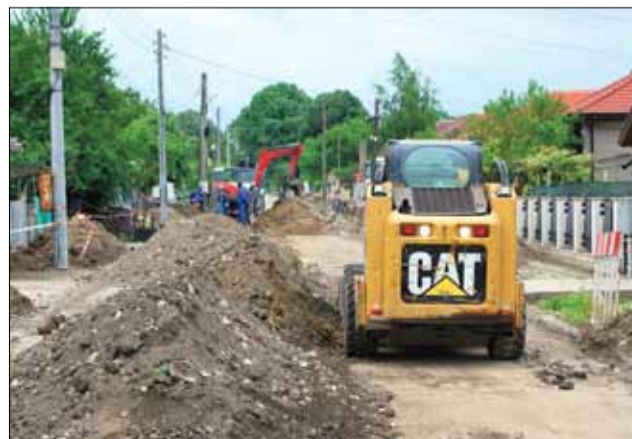
Ул. „Васил Алексиев“ в началото на строителните дейности.
