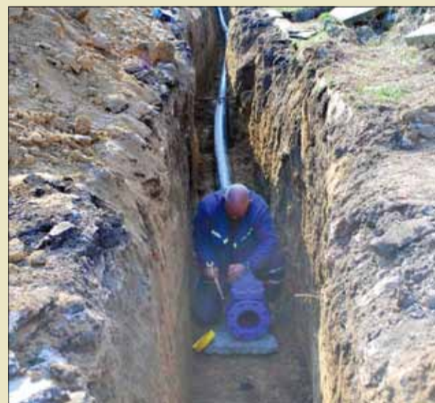
Разкопаването на улиците в село Спасово тъкмо започна, докато в село Кардам вече лягат и поставят тръбите по трасето.
