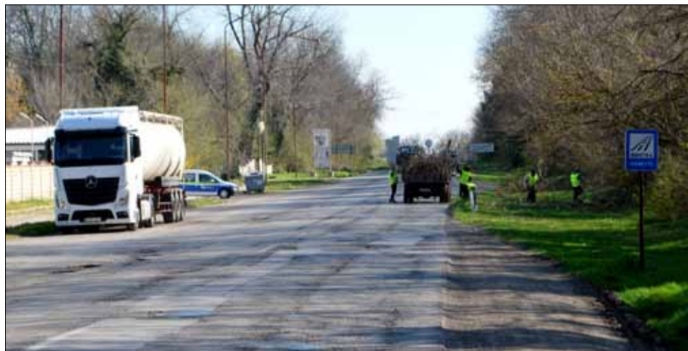
Рехабилитацията на трасето започна с настрење и почистване на храстите и дърветата край пътната настилка.
