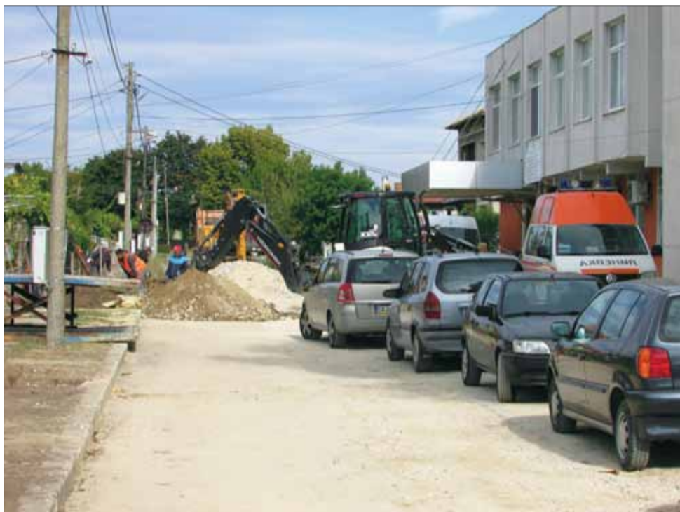
По ул. „Иван Вазов“ в град Генерал Тошево се работи с бързи темпове.
