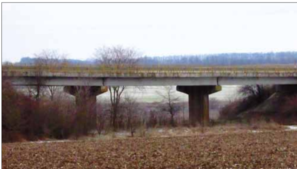
Това е злополучният ЖП надлез, който спря ремонта на пътя Генерал Тошево – ГКПП Кардам. Според специалисти от Института по пътища и мостове, на съоръжението има деформации на мостовата конструкция на стълб 2 и има предпоставки за аварийно състояние.
