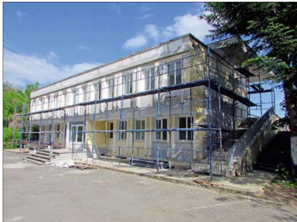
Стадион „Спортист“ в началото на строителните дейности
